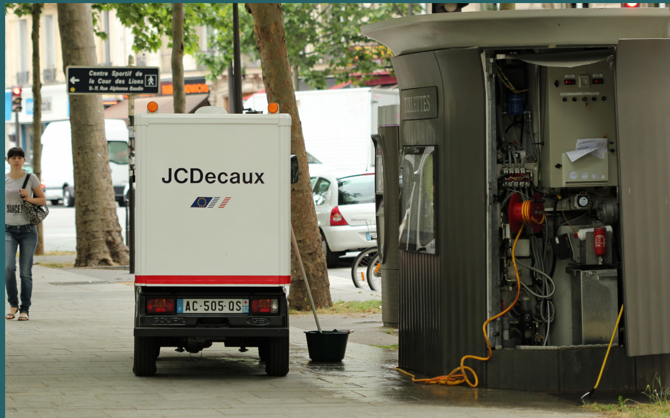
JCDecaux sanisette maintenance (Coyau / Wikimedia Commons / CC BY-SA 3.0, Boulevard Richard-Lenoir (Paris), entretien d'une sanisette 02, CC BY-SA 3.0)
